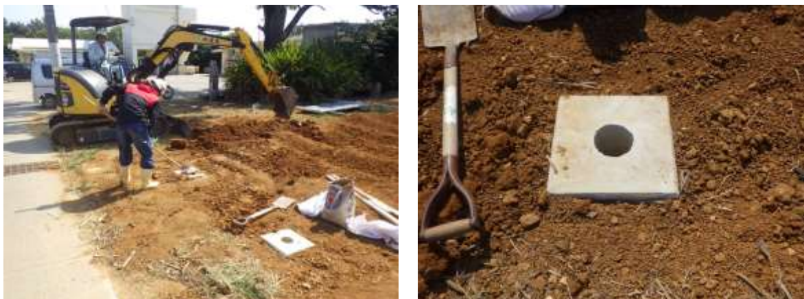
写真 1. コンクリート基礎据付け工事の様子
